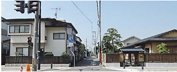
写真10 既存の塀・門を活用した右西24、左新設の塀
