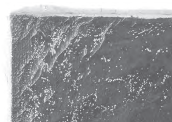
図4 画面左上の剥落箇所修復前
