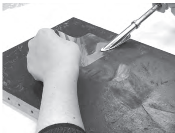
図6 亀裂の接着強化
