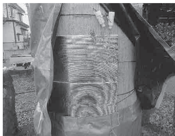
写真2 養生内部に断熱材の設置状況
