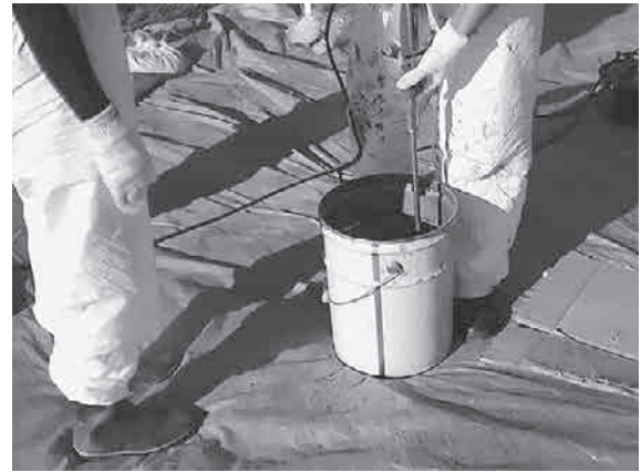
写真8. 水と樹脂を入れミキサーで混合しエマルジョンを作成している様子
