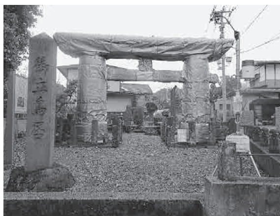
写真1 石鳥居の冬季養生の様子
