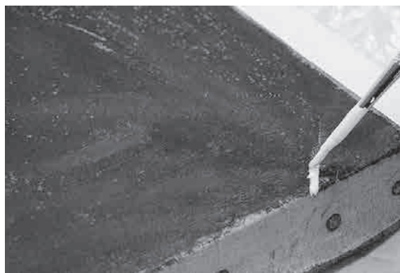
図32. 亀裂開口部の充填
