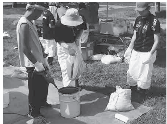
写真9. エマルジョンと土をミキサーで混合している状況
