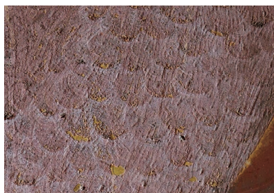
図6. 紅い羽部分（修理前）
