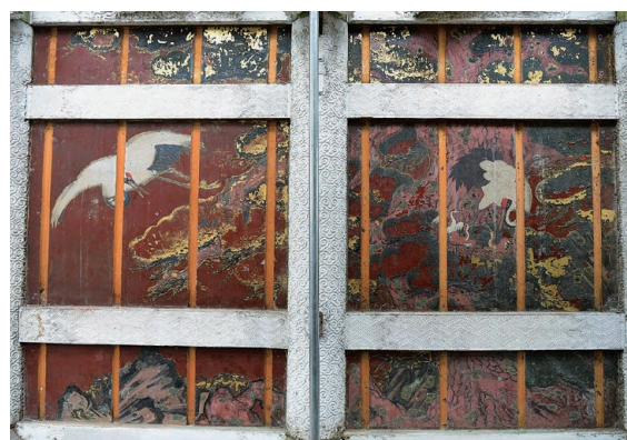
図2. 西側壁面全体図（修理前）
