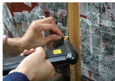
図17. 加湿・加温して養生紙を除去
