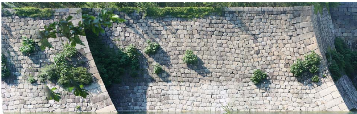
写真2 鍋嶋組本石垣の現状(南から)
