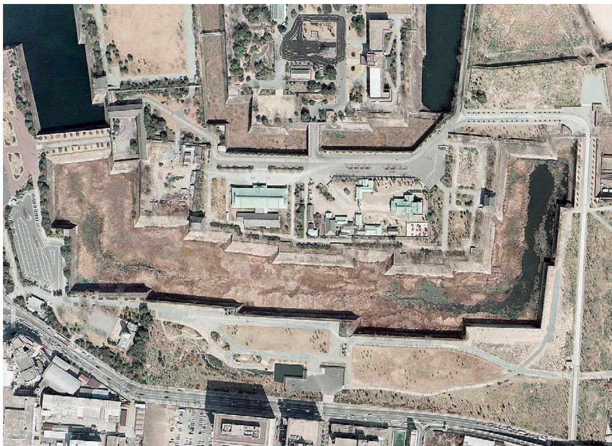
写真1 水が枯れた南外堀(撮影1975年3月14日CKK748-C15-22国土地理院)
