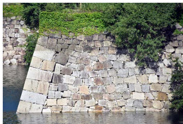
写真3 水敲83号壁の現状(西から)
