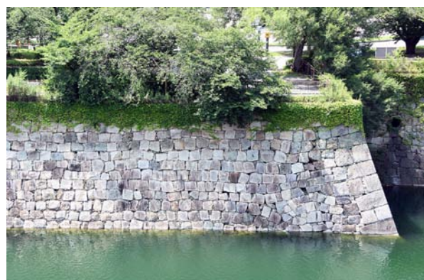
写真4 水敲84号壁の現状(北から)
