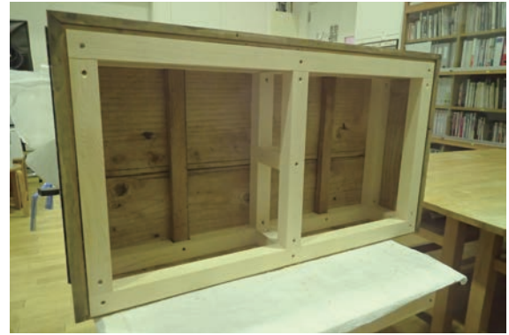
▲基台内部に新規構造材を設置
