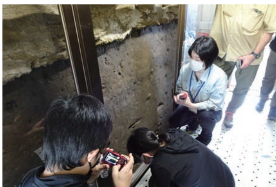
写真4 塩類及び放線菌の除去作業の様子
