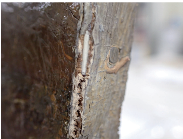
図29. 側面の破れ箇所の補修②
