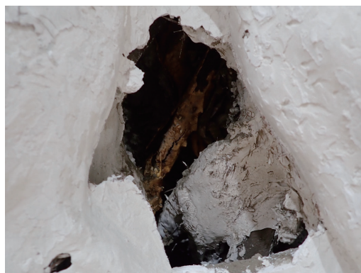
図2 切断して取り外した状態
