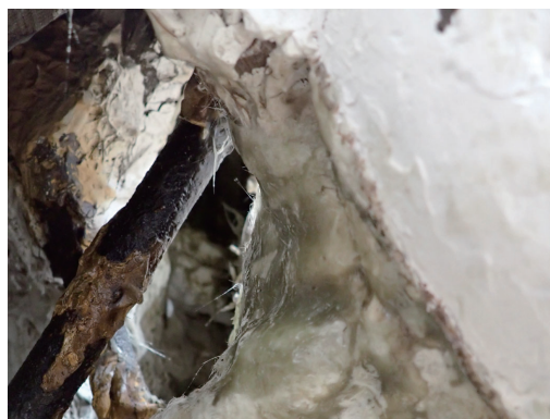
図4 ガラスクロスで内部を補強した状態
