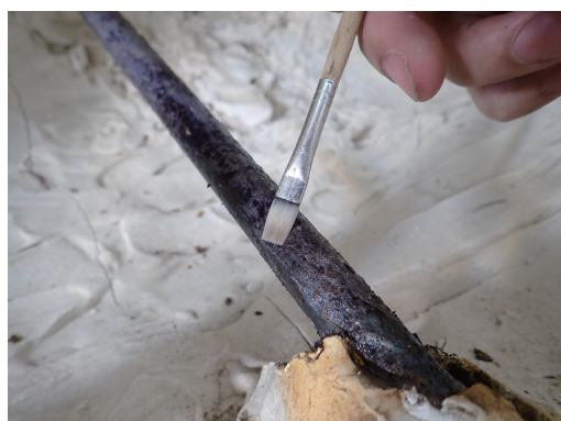
図7 防錆剤を塗布している（丸棒）
