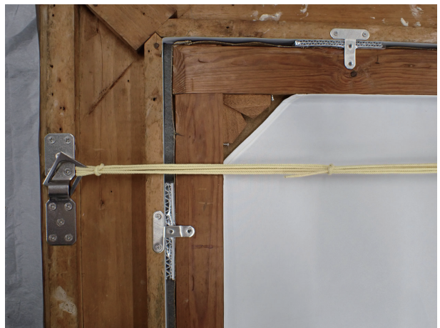
図42. 新規の吊り金具と吊り紐
