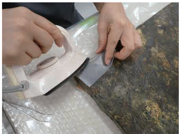
図30. 側面の破れ箇所の補修③
