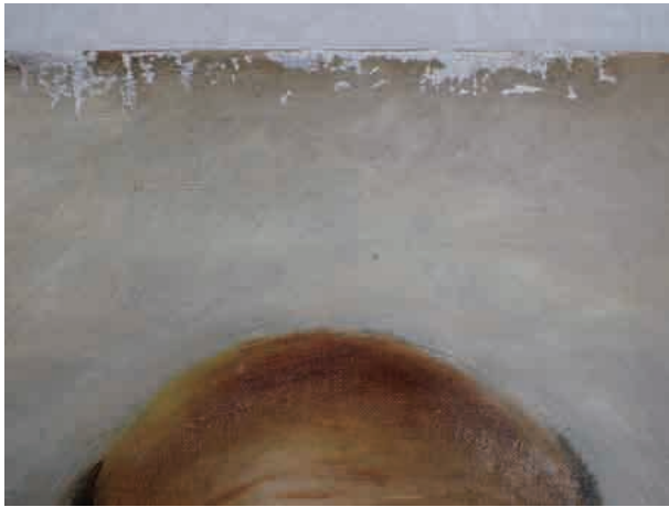
図23. 欠損部の充填後
