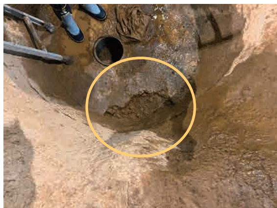
Fig.1 柱穴底面および壁面の破損
