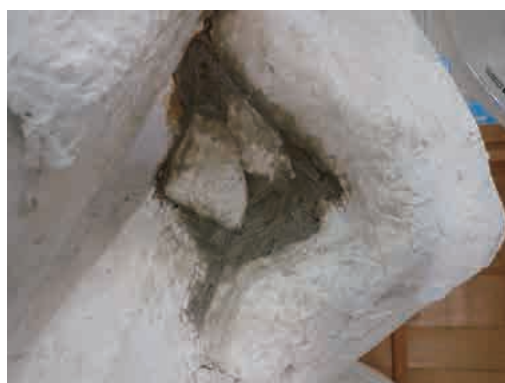
図5 取り外した石膏層を戻して接着した状態
