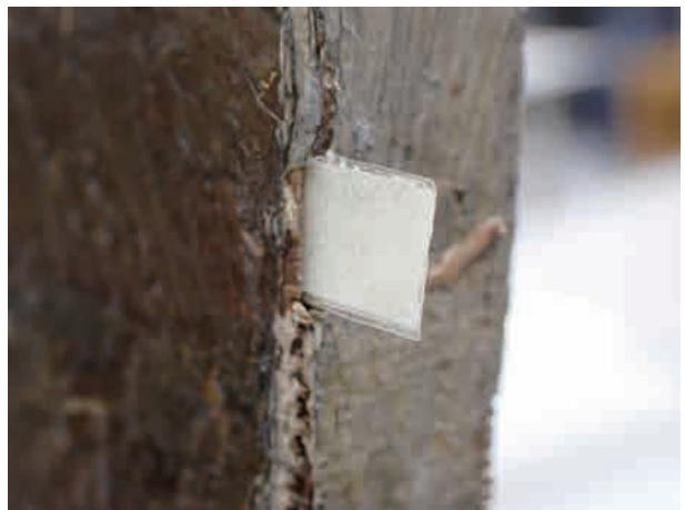
図28. 側面の破れ箇所の補修①
