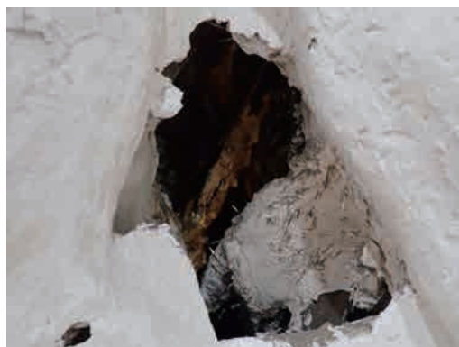
図2 切断して取り外した状態
