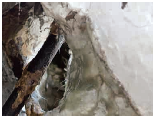
図4 ガラスクロスで内部を補強した状態
