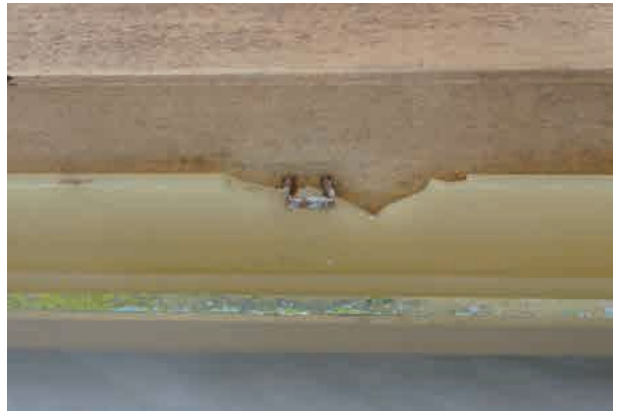
図44. 入子の破損箇所
