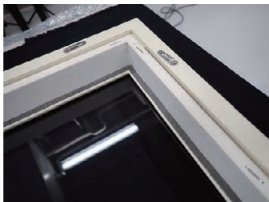
図2-23. 入子内側の養生後
