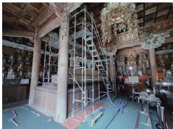
図5 足場7月 西島上高所像の安置
