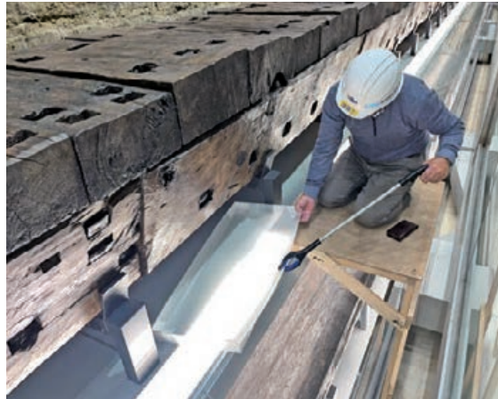
図4 堤体落下物の受け箱を回収する様子
