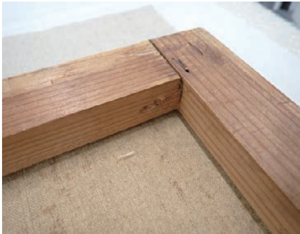
図1-9. 木枠の角の接合部分
