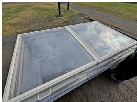
Fig.3 アクリル蓋の結露の様子
