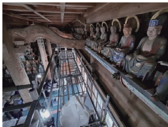
図7 足場11月 南面高所像の移動
