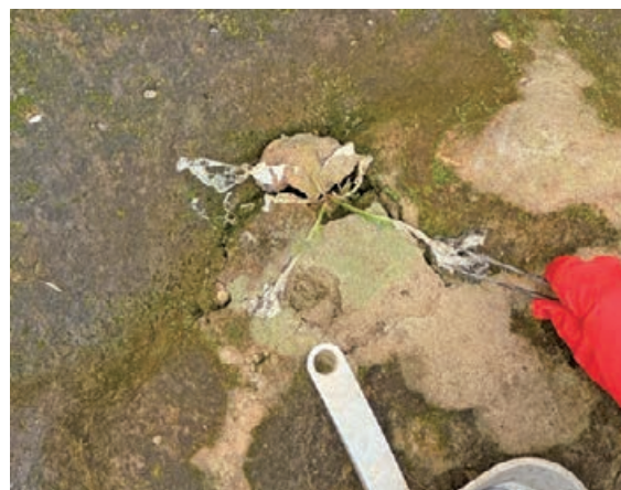
Fig.1 遺構面に生えていた雑草 除草剤塗布後
