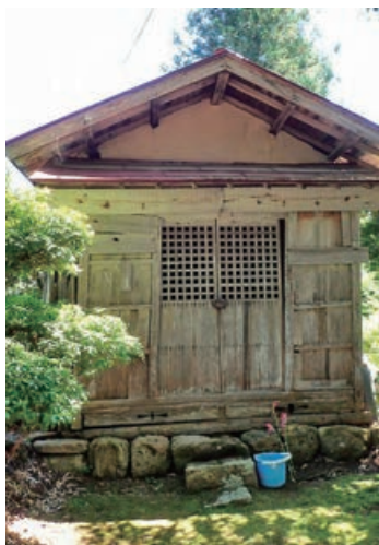
図1 取り壊し前の経堂
