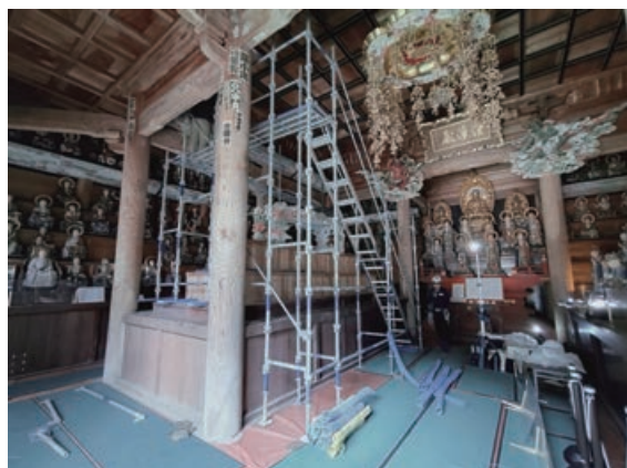
図5 足場7月 西島上高所像の安置
