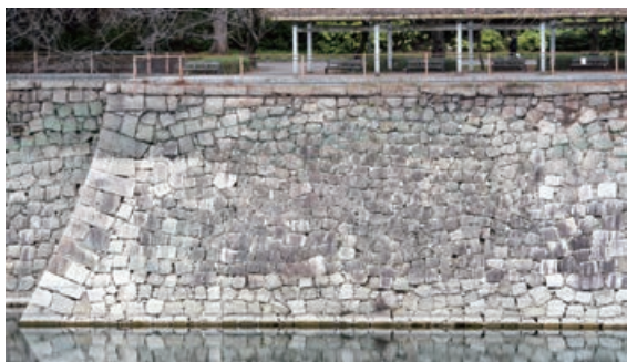
図6 南外堀水敲76号壁 立花家丁場
