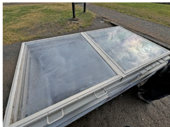
Fig.3 アクリル蓋の結露の様子
