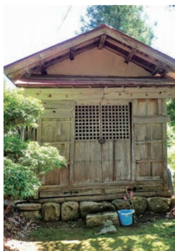
図1 取り壊し前の経堂
