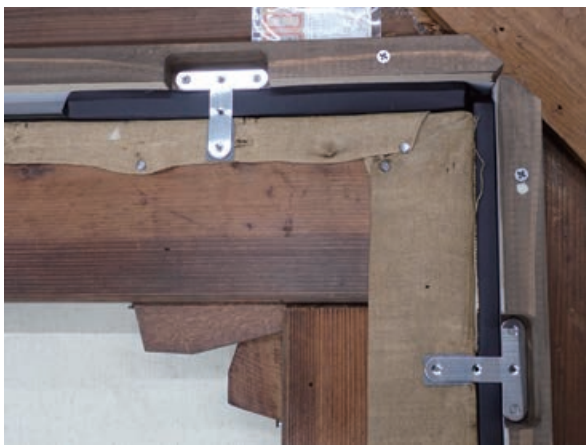
図35. 額と作品の隙間を補填し固定
