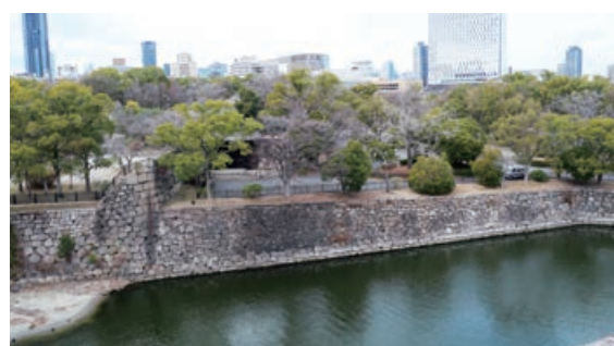
図4 西内堀水敲152号壁
