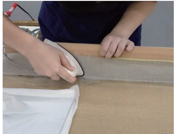
図1-22. 張りしろの補強
