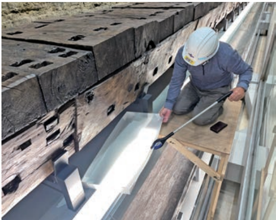
図4 堤体落下物の受け箱を回収する様子
