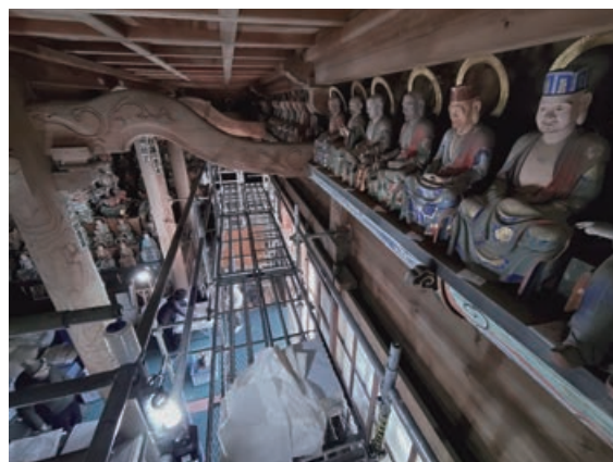
図7 足場11月 南面高所像の移動
