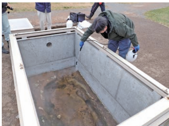
Fig.2 強化処理作業（OM10噴霧）
